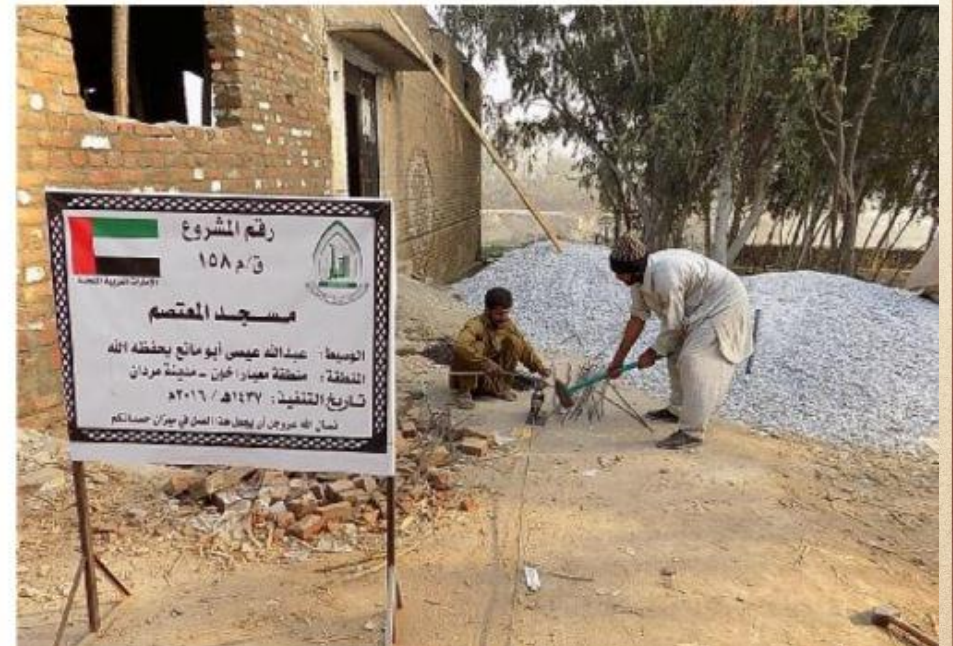
مشروع بناء بيت في الجنة / مسجد المعتصم (ق/م ١٥٨)
