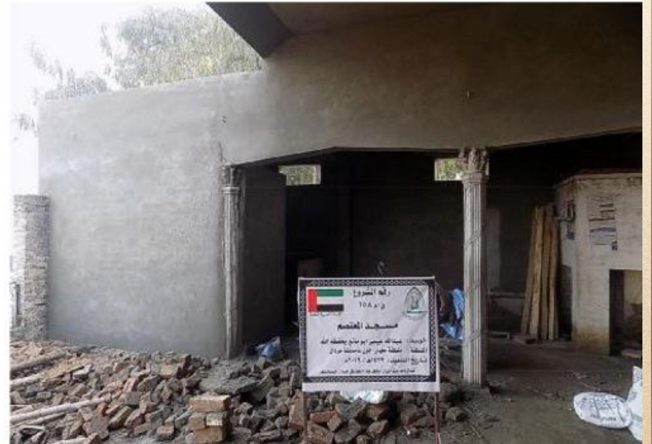
مشروع بناء بيت في الجنة / مسجد المعتصم (ق/م 108)
