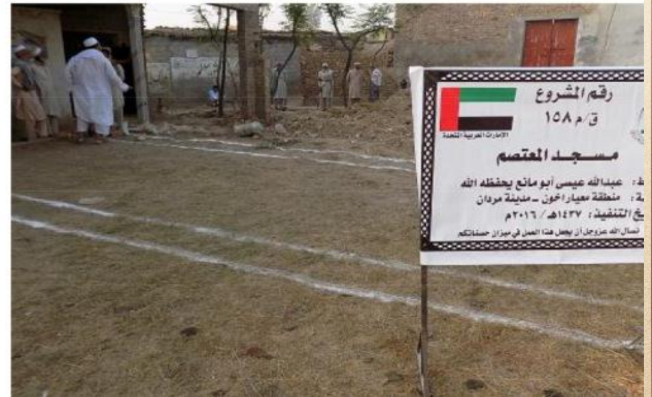
مشروع بناء بيت في الجنة / مسجد المعتصم (ق/م ١٥٨)
