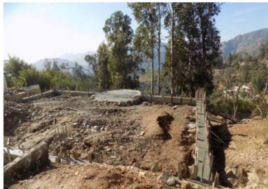
مشروع بناء بيت في الجنة / مسجد حصه بنت مشاري الكليبي (م/ق ٢٧٦)
