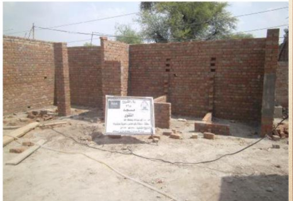
مشروع بناء بيت في الجنة / مسجد التقي (ق/م/٣٦٨)
