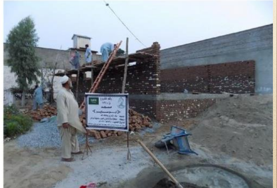
مشروع بناء بيت في الجنة / مسجد أبو سائر (ق/م ١٧١)
