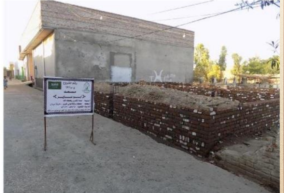
مشروع بناء بيت في الجنة / مسجد أبو سائر (ق/م 171)
